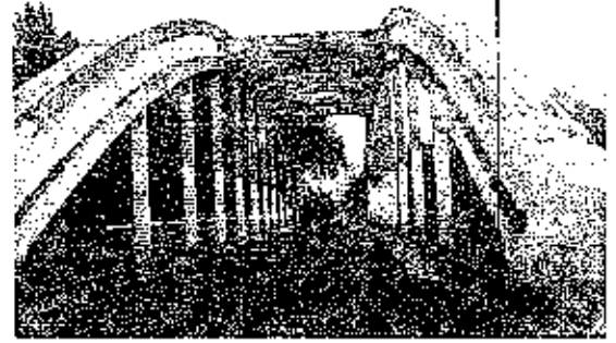
Puente de la Ruta Provincial Nº 25 sobre Río Luján
