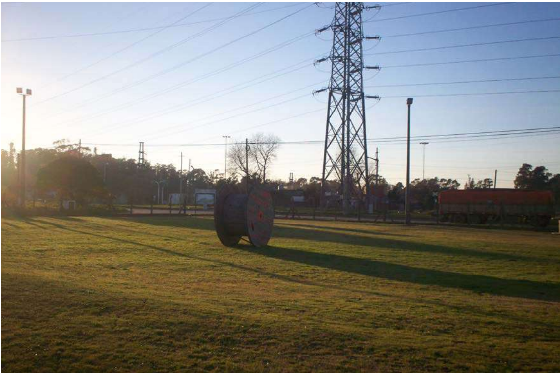
Fotografía 18. Vista del futuro sector de obra desde el predio de la ET.
