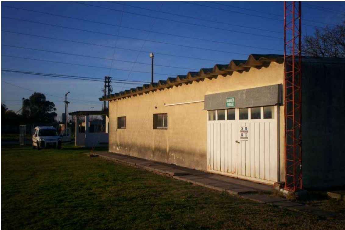
Fotografía 19. Vista de la sala de celdas 33 kV de la ET.
