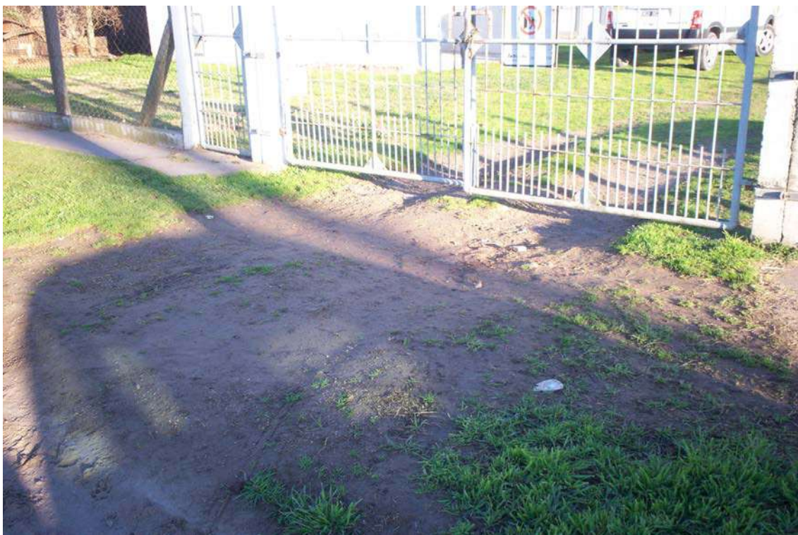
Fotografía 15. Vista del sector de acceso al predio de la ET.
