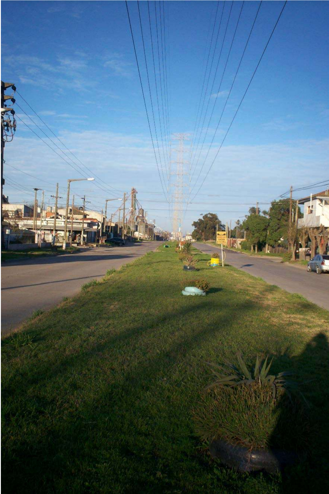
Fotografía 6. Vista del boulevard de la Av 542 desde la calle 529 hacia el SO.
