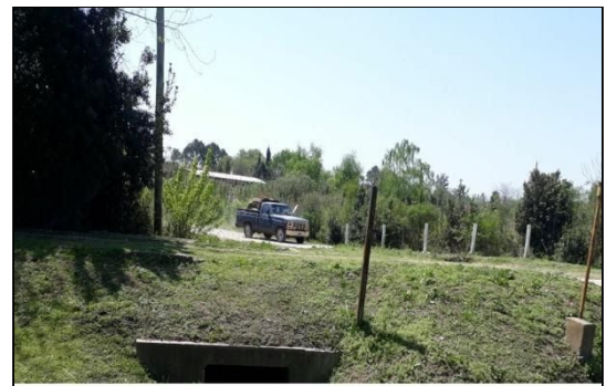
Ilustración 5: Calle 113 y 40 (vista aguas abajo).
