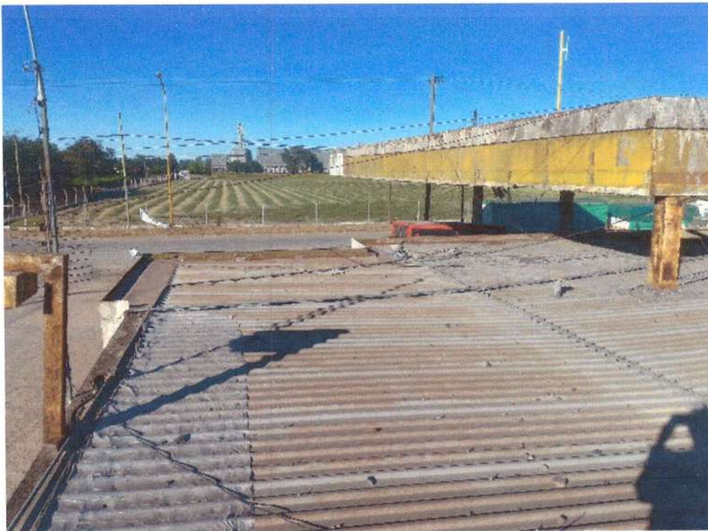
Estado actual de cubierta
