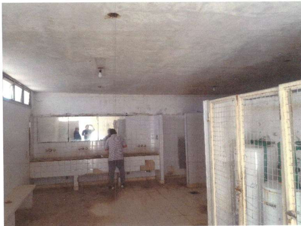
Estado actual de vestuarios
