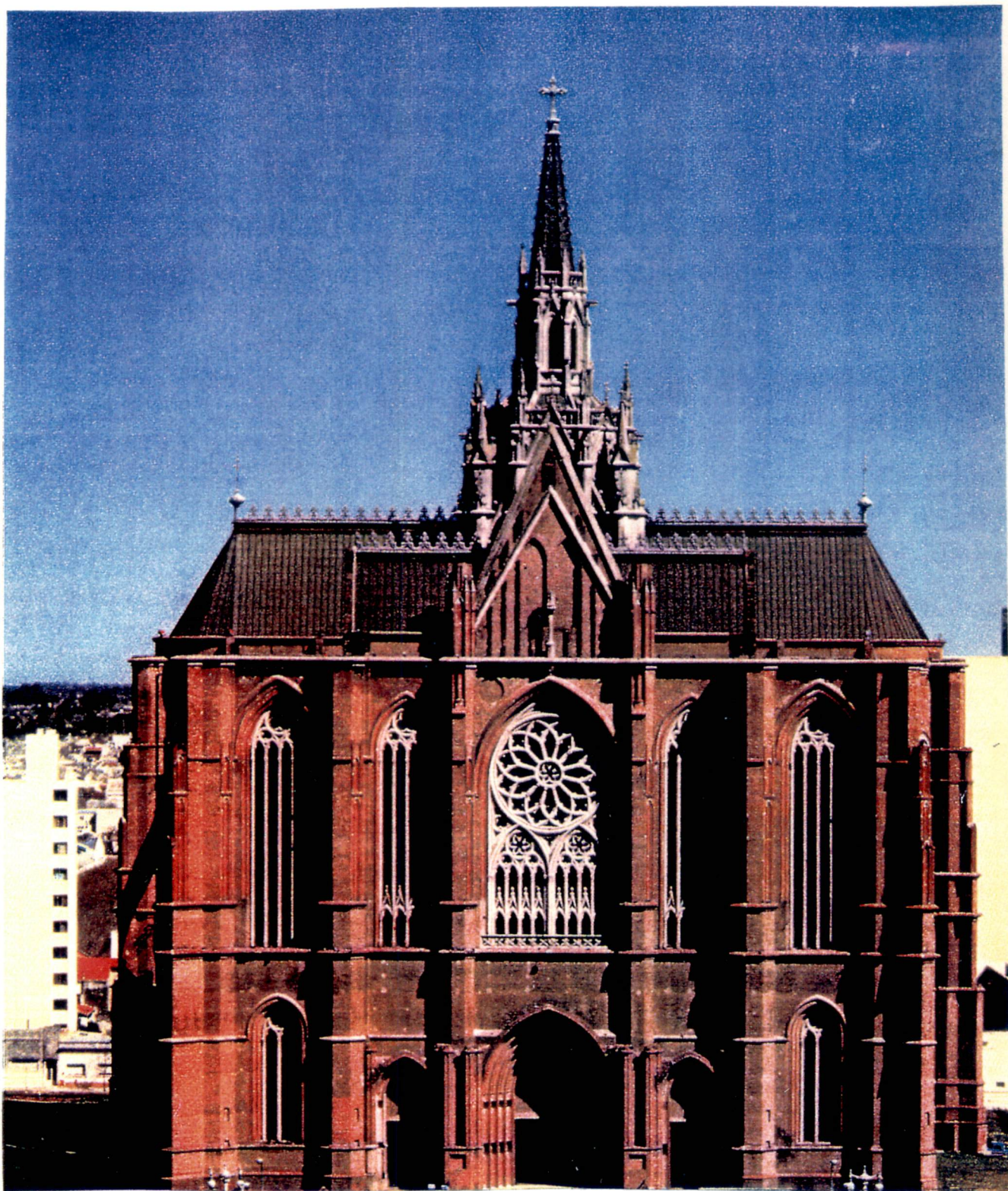
FACHADA SOBRE CALLE 14; ESTADO ACTUAL
