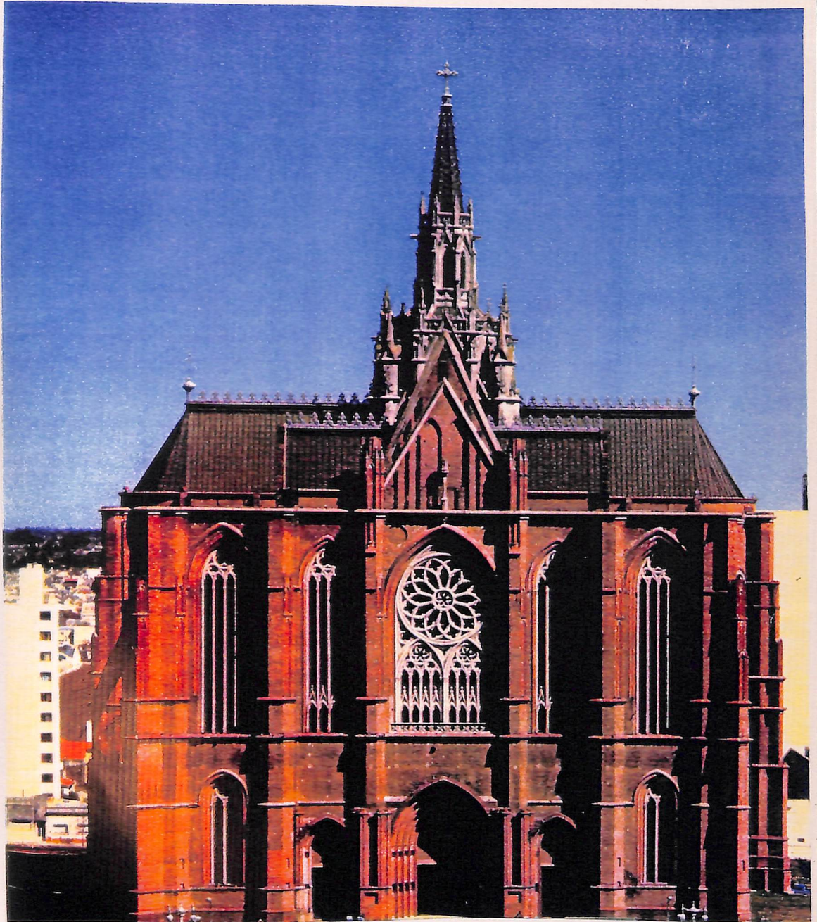
FACHADA SOBRE CALLE 14; ESTADO ACTUAL
